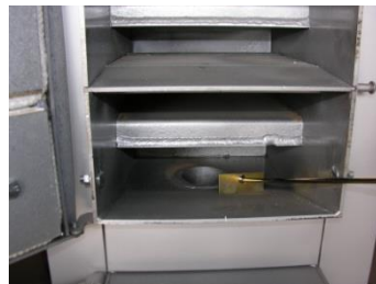
Fot.6. Pozostałości pyłu zgarnąć gracą do otworu wymiennika.
