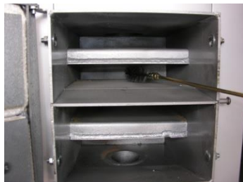
Fot.5. Powierzchnie wymiennika czyścić szczotką lub odkurzaczem.
