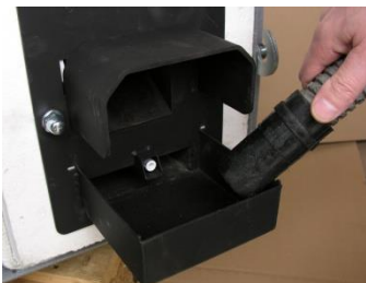
Fot.4. Czyszczenie komory powietrznej palnika QPell
